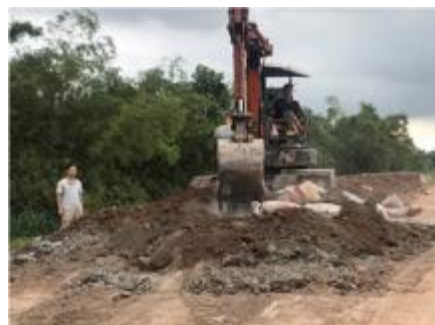
Hình 1.4 - Các loại công nghệ đề xuất: a- Công nghệ trộn khối và b- Gàu đào có răng.
