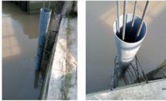
Hình 27. Ống PVC Ø250 mm được đặt xuống dưới lòng sông cặp thành bê tông.
