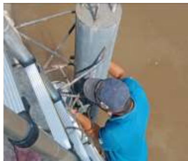
Hình 29. Gia cố trụ bê tông vào thành sàn bê tông.
