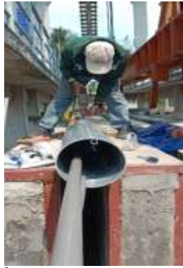
Hình 30. Gắn ống \varnothing 21 mm vào ống PVC \varnothing 220 mm để tạo đường ray dẫn hướng cho phao chứa cảm biến.
