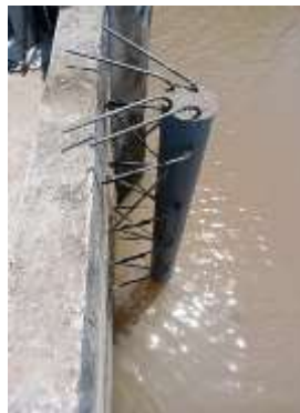
Hình 28. Đổ bê tông vào ống PVC Ø250 mm.
