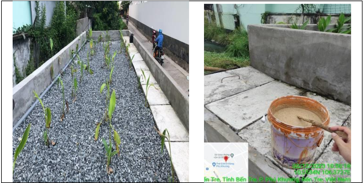
7 Hoàn thiện hệ thống xử lý và lấy mẫu kiểm tra, theo dõi
