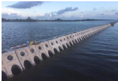
Hình 6.11. ĐGS lắp đặt cấu kiện BT cốt phi kim đúc sẵn hình thang cân (trái), dạng trụ rỗng (phải) tại xã Khánh Bình Tây, huyện Trần Văn Thời
