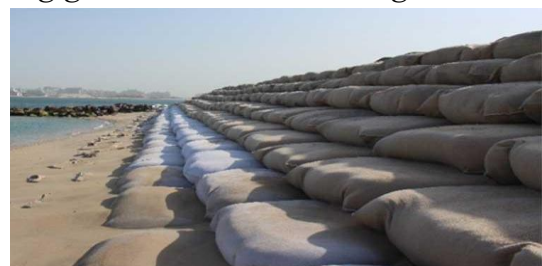
Hình 6.4. Một số loại hình gia cố bờ biển (nguồn Van Rijn, 2010) (trái), gia cố bờ biển bằng bao cát, bao đất tại Ấn Độ (phải)
