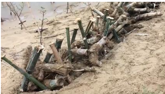
Hình 6.47. Kết cấu khóa 2 (trái), Kết cấu mái kè đai ở giữa (phải)
