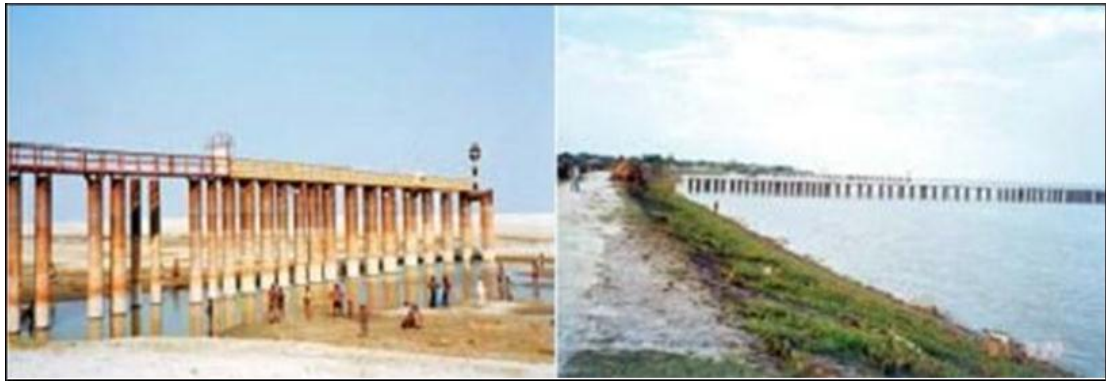
Hình 6.13. Kè mỏ hàn bằng hai hàng cọc ống BTCT trên sông Brahmaputra, Băng La Đéc.
