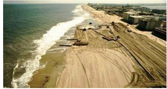
Hình 6.1. Nuôi dưỡng đụn cát, bãi biển (nguồn Van Rijn, 2010) (trái), thực tế (phải)
