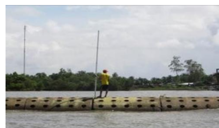
Hình 6.11. ĐGS lắp đặt cấu kiện BT cốt phi kim đúc sẵn hình thang cân (trái), dạng trụ rỗng (phải) tại xã Khánh Bình Tây, huyện Trần Văn Thời
