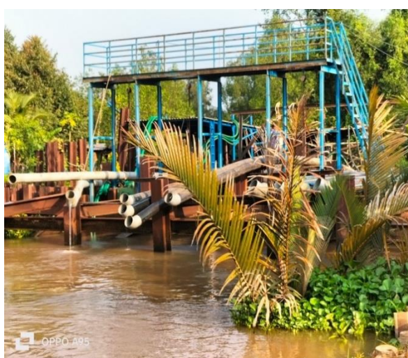
Hình 3. 1. Cống, đập tạm ngăn mặn kết hợp bơm lấy nước trữ ngọt mùa khô
