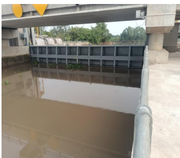
Hình 3. 1. Cống, đập tạm ngăn mặn kết hợp bơm lấy nước trữ ngọt mùa khô
