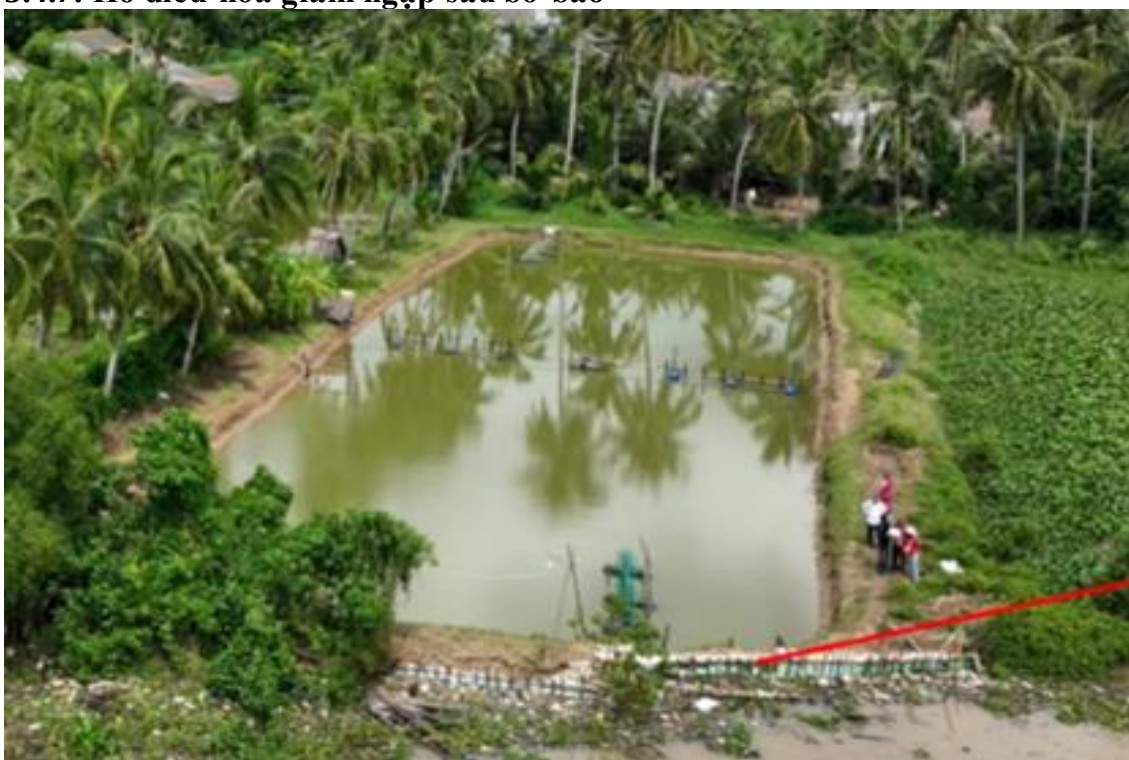
Hình 5.23. Ao cá không sử dụng có thể tận dụng làm hồ trữ nước ngọt hoặc sử dụng khi ứng phó sự cố vỡ bờ bao
